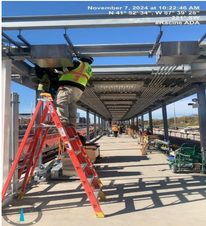
Racine Concourse Extension Conduits
