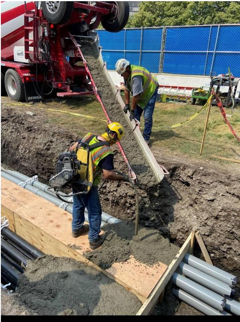
Pouring Concrete Ductbank for Conduit
