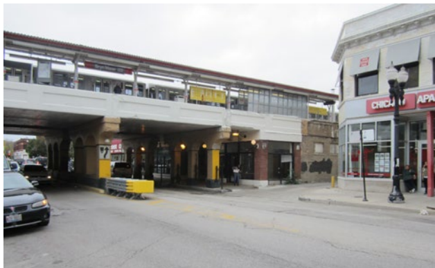
Viaductos existentes en la estación de Bryn Mawr
