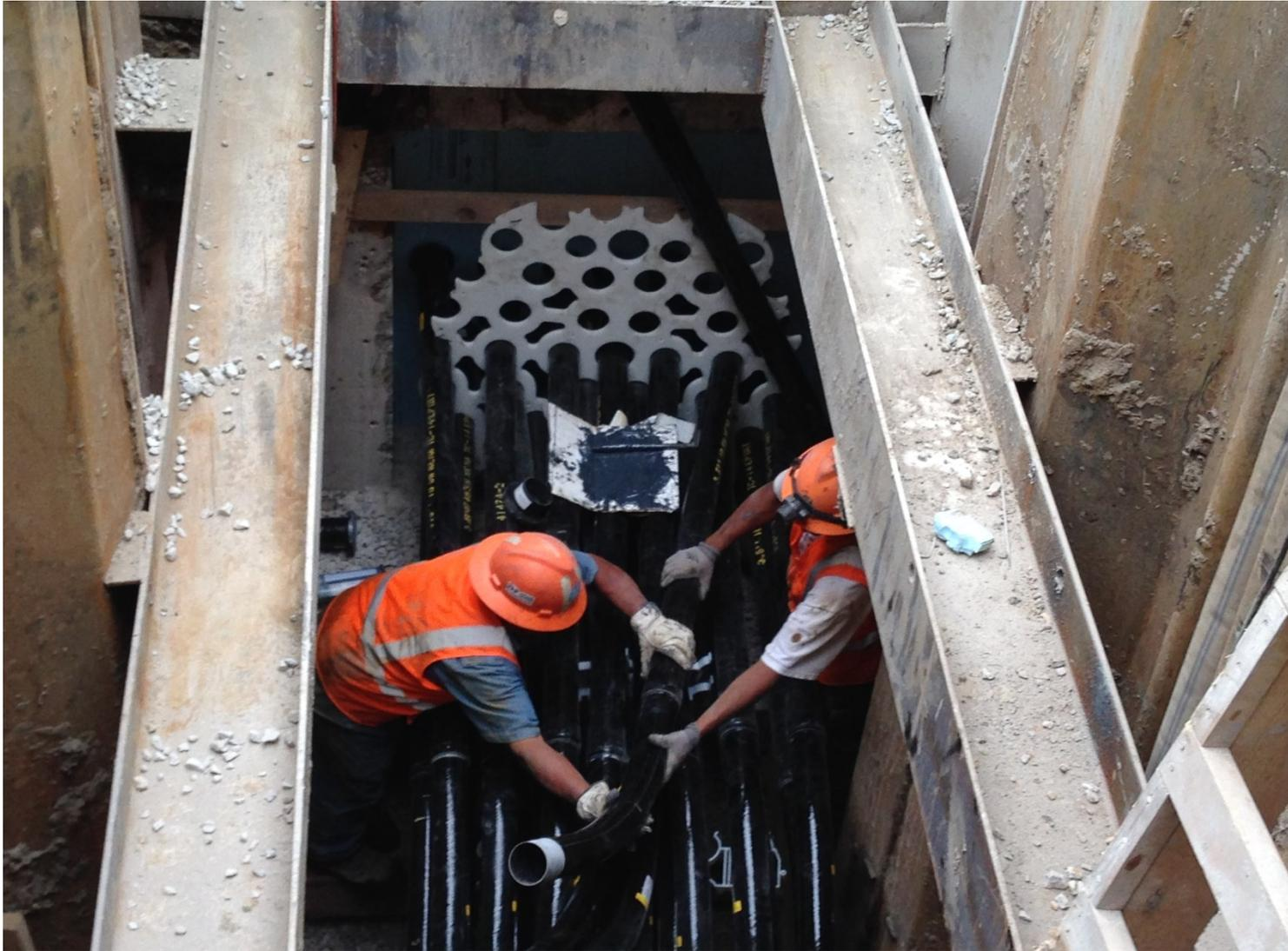
**Hill Ductbank: conduit installation**
