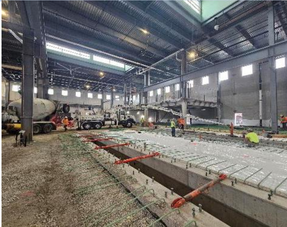
Slab on Grade Pour #3B – Facing North
