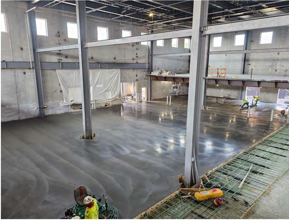
Slab On Grade Pour#1
