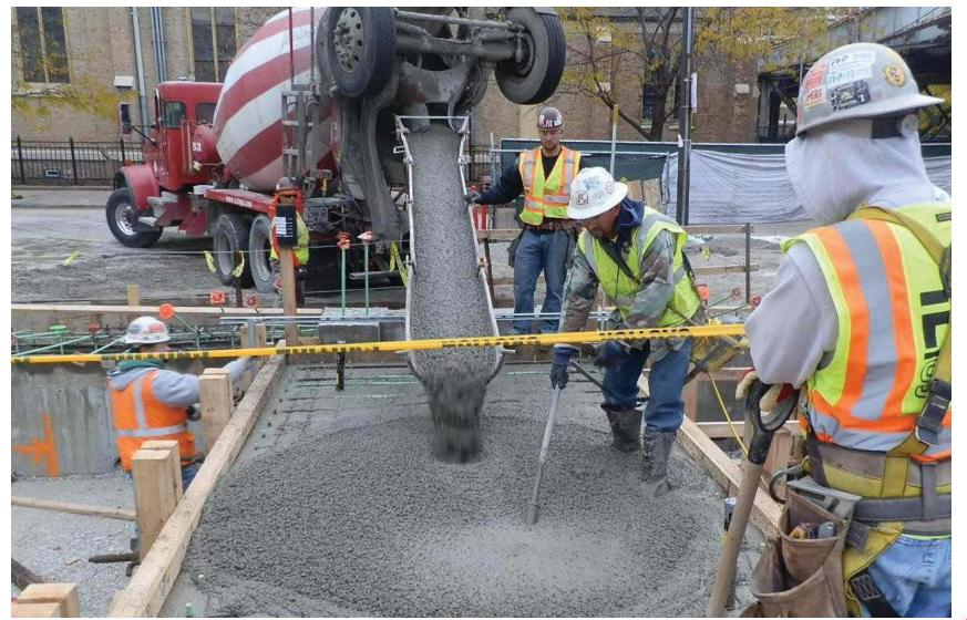
Hill Substation: transformer pad concrete pour
