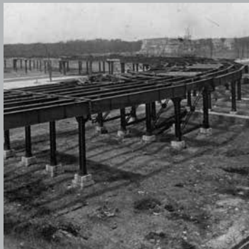
Construcción de la curva de Sheridan, abril, 1897
