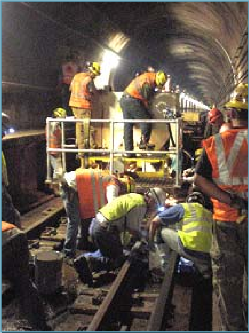
Crews pouring concrete
