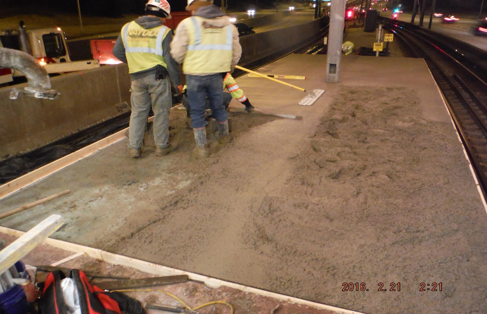
Addison concrete topping slab pour
