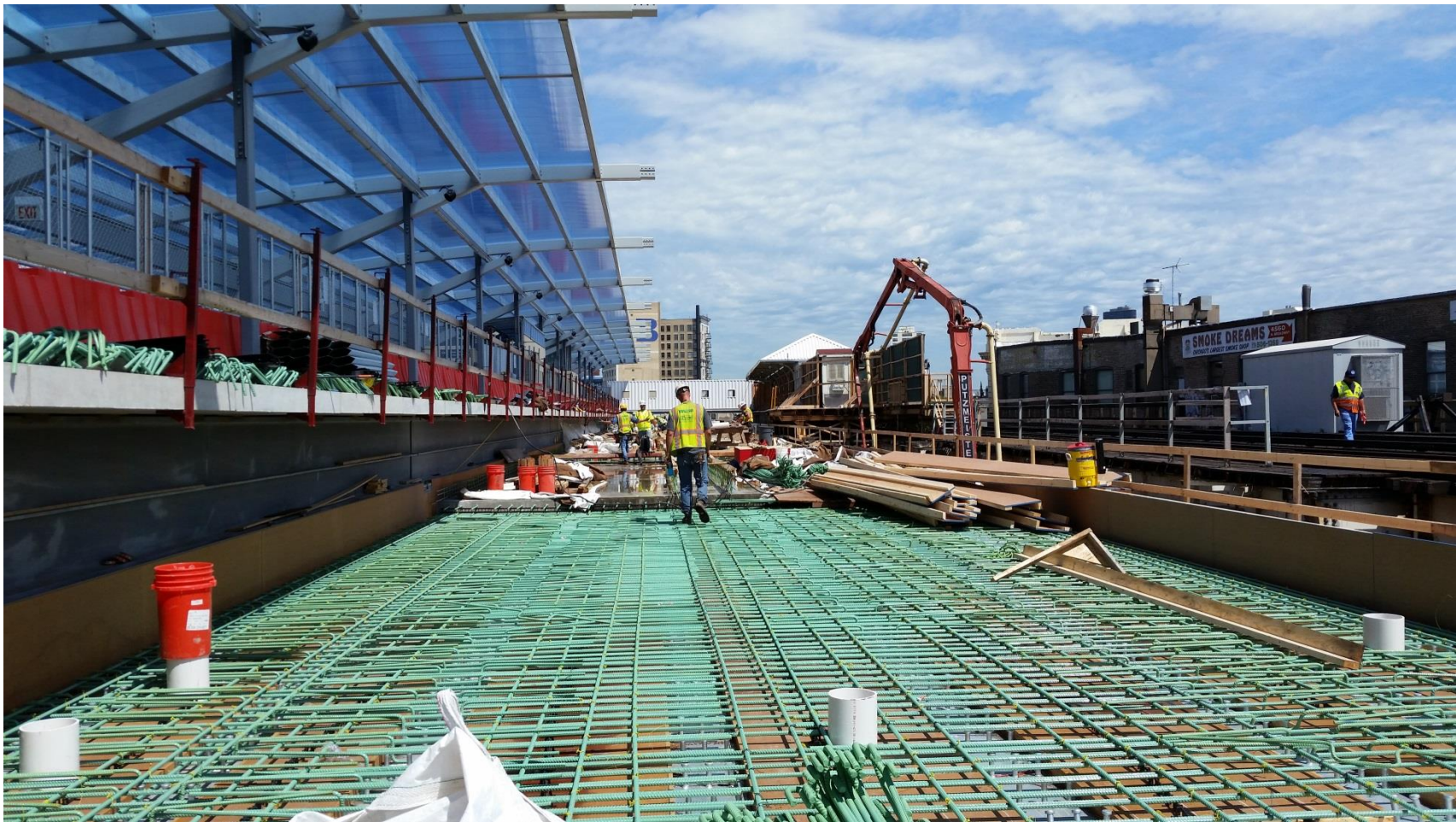
New track 2 rebar installation for structural deck pour
