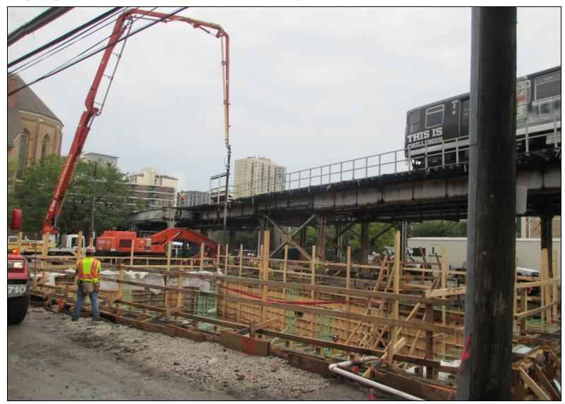
Hill Substation foundation wall concrete pour
