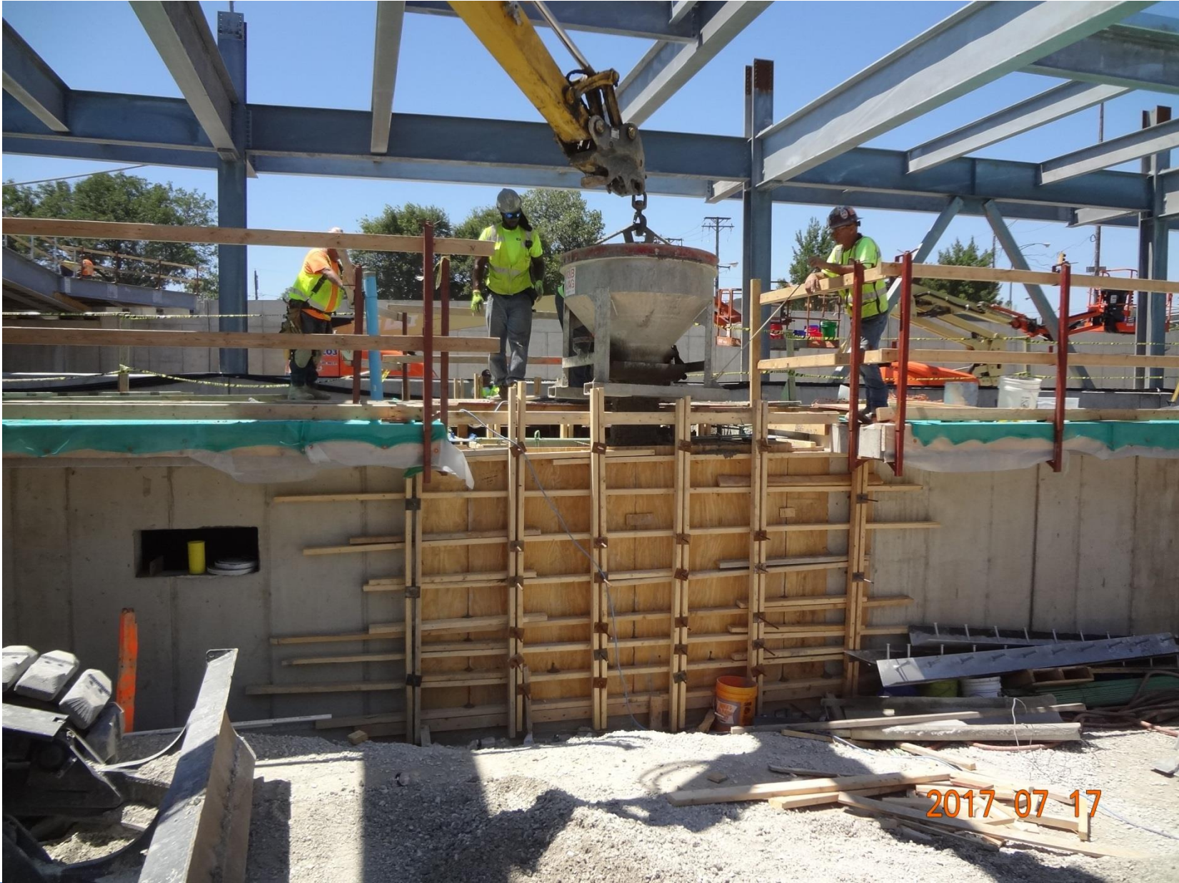
Concrete Pour for Elevator Shaft Pit Walls
