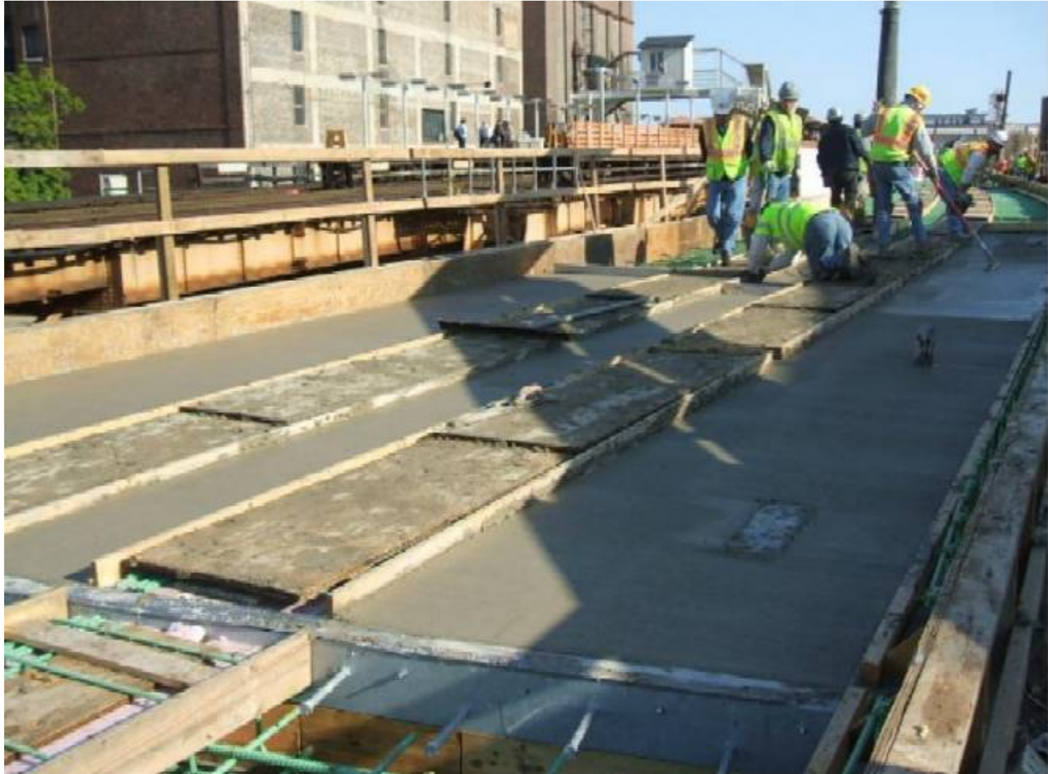
Concrete track bed pour at Belmont
